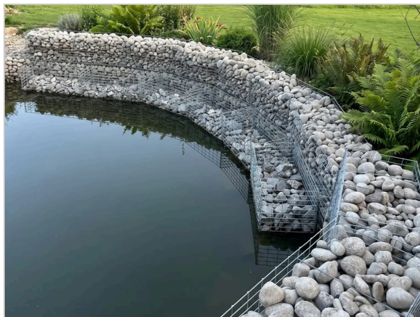
Gabionové koše s okruhliakmi — spevnenie brehu jazierka
